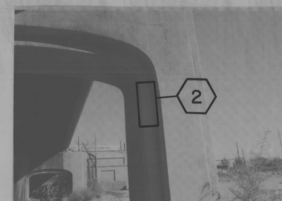
PHOTO Nº 22 PIER Nº 14 Westside - South Column
