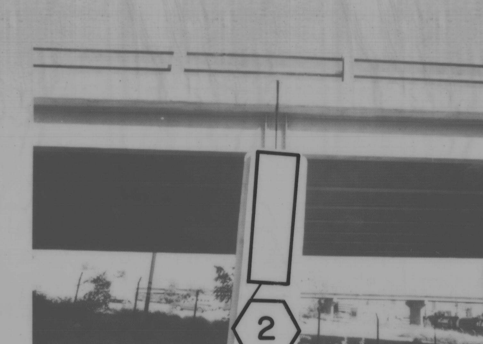
PHOTO Nº 24 PIER Nº 14 Southend
