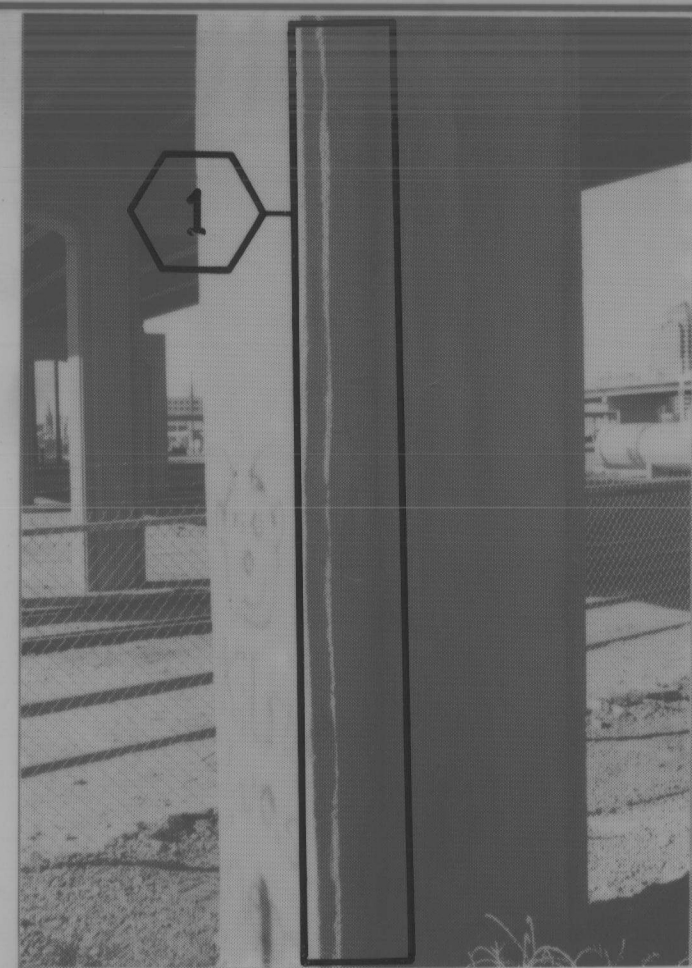
PHOTO Nº 16 PIER Nº 12 Eastside - 2 ND Column from Southend
