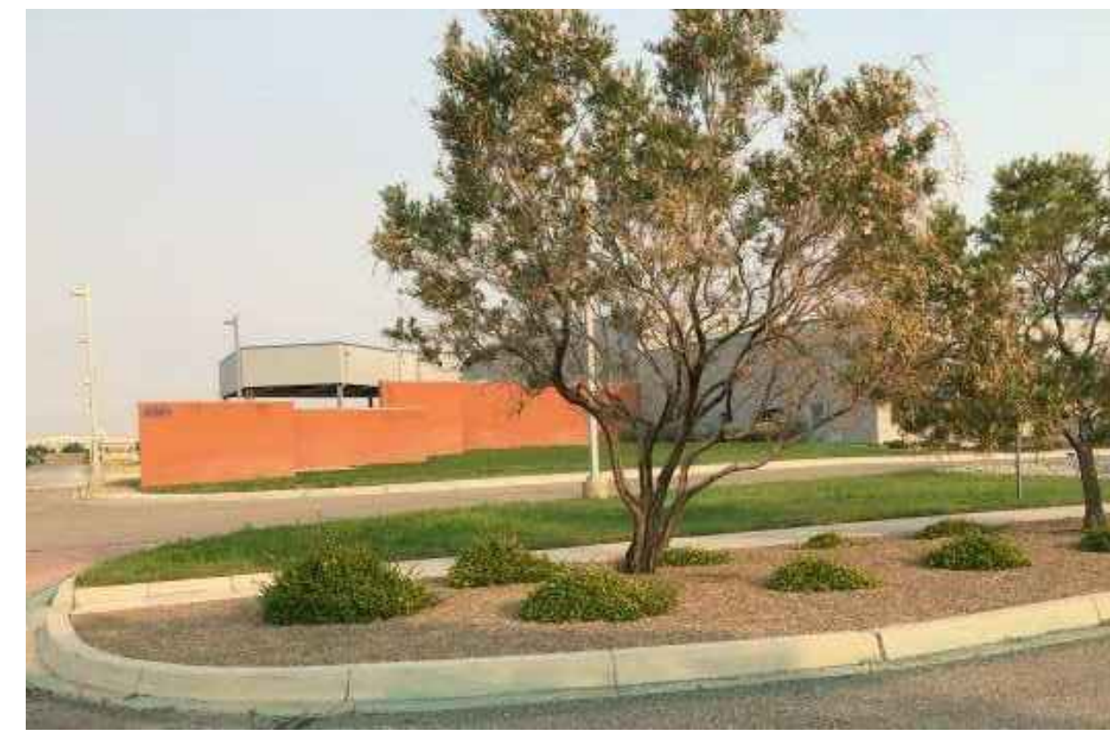
B5 EXISTING FRONT LANDSCAPING N.T.S.
